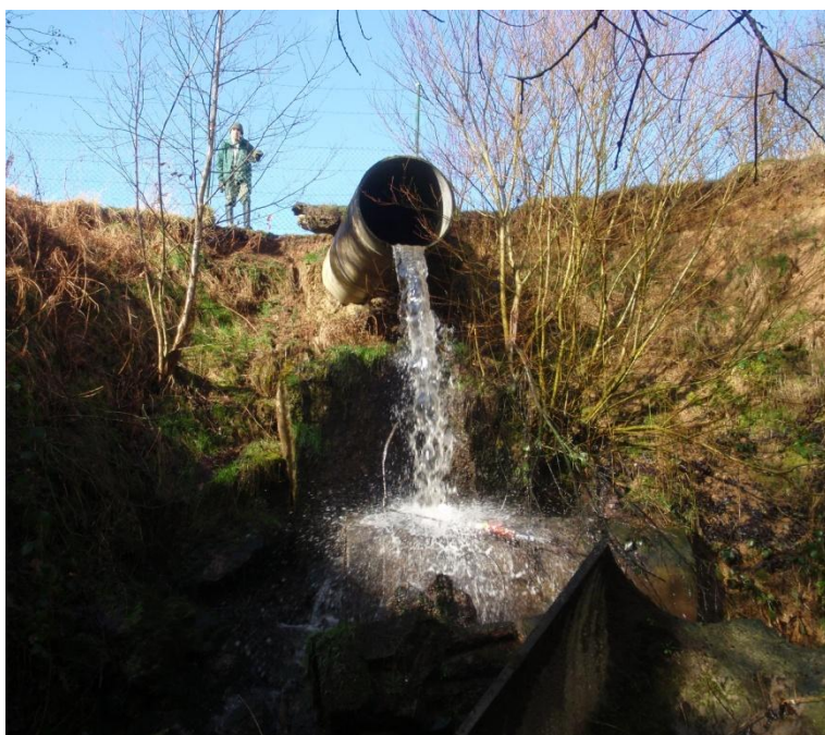
L'arrivée d'eau au trou du Taureau.
