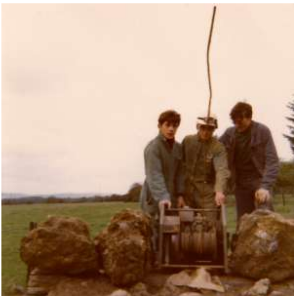
A l'Agole en 1968... En haut à gauche : à l'entrée, avec le vieux trépied. A droite : le puits d'entrée. Au milieu à gauche : le puits cerclé. Ci-dessus : à l'entrée, on devine la nouvelle chèvre. Ci-contre : le treuil.
