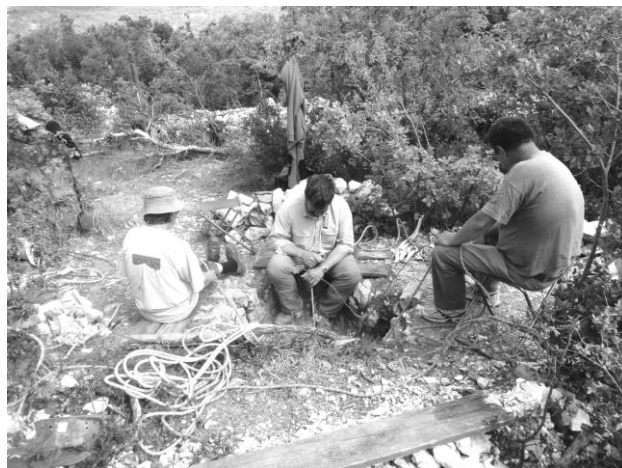
Le chantier sous le soleil.
